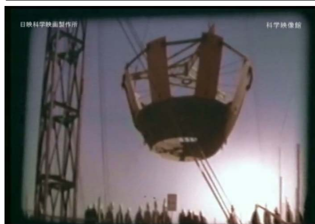
昭和42年10月、格納容器の組み立て開始(建設編より)
