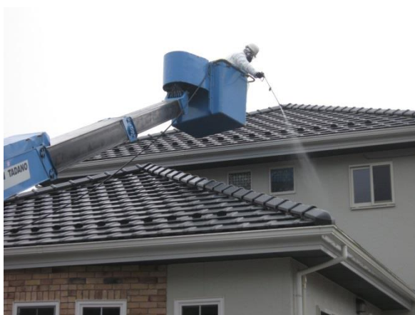
過酸化水素水を屋根に吹きかけます
