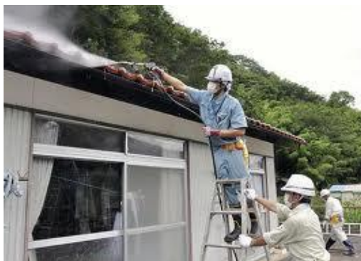
高圧洗浄（写真福島市）
